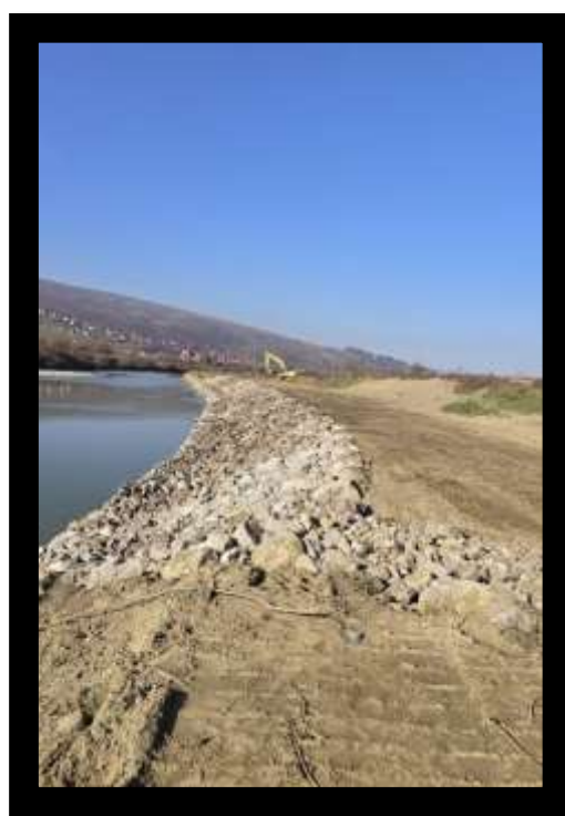
Consolidare cu piatră brută mal drept r. Olt la Căpeni, L =150 m
