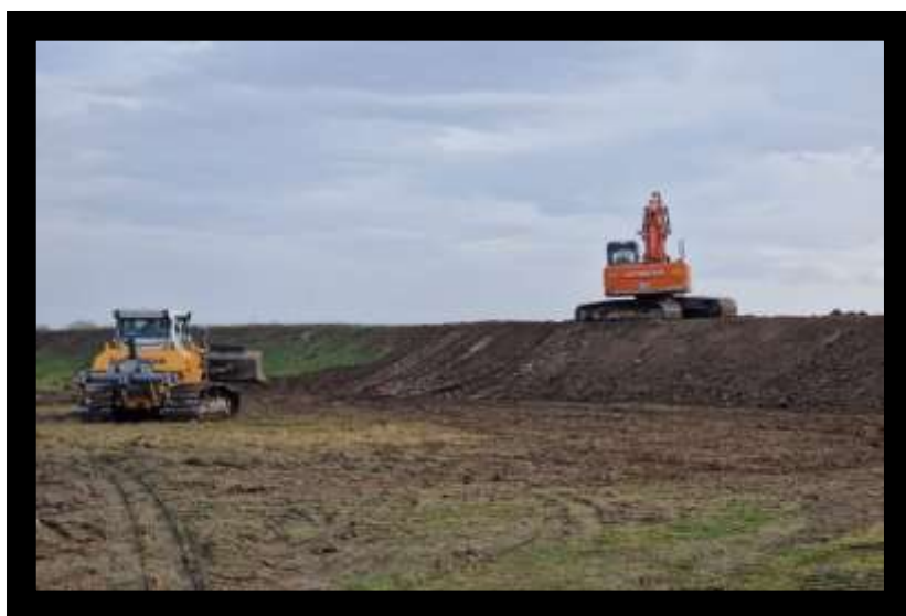
Aducere la cotă dig r. Olt la Făgăraș
