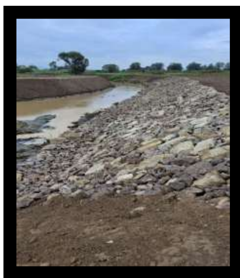
Rep. Consolidare cu piatră brută pr. Târlung, mal drept, loc. Lunca Mărcuşului, L=90 m
