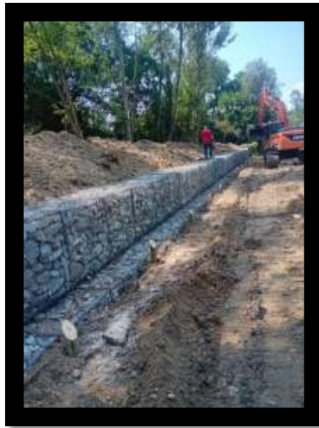
Reparație curentă gabion mal stâng pe pârâu Govora la Mihăești
