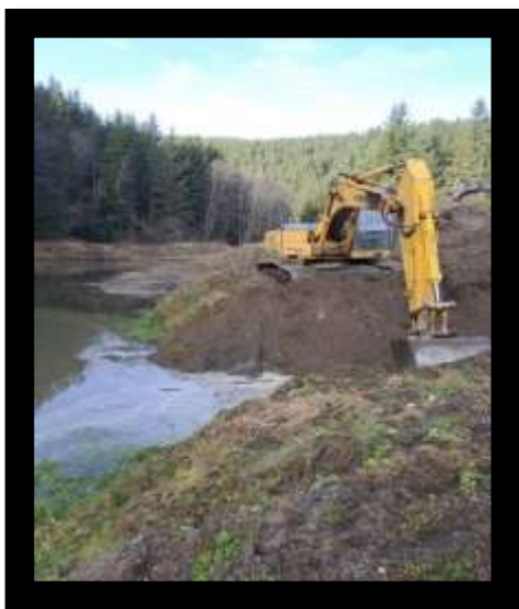
Decolmatare lac amonte baraj mic ac. Mesteacănu-Bălan
