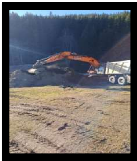
Decolmatare lac amonte baraj mic ac. Mesteacănu-Bălan
