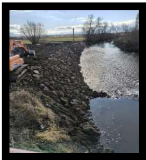
Intervenție corectivă pentru stopare eroziune cu piatră brută, r. Olt, mal stâng, intravilan Siculeni, aval pod, L = 60 ml, hm 5840 - 5841
