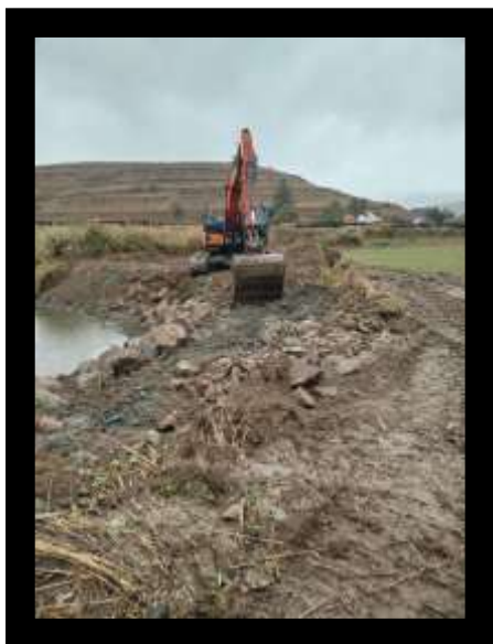
Intervenție corectivă pentru stopare eroziune cu piatră brută, r. Olt, mal stâng - mal drept, amonte loc. Mădăraș, L = 60 ml, hm 5930 - 5931
