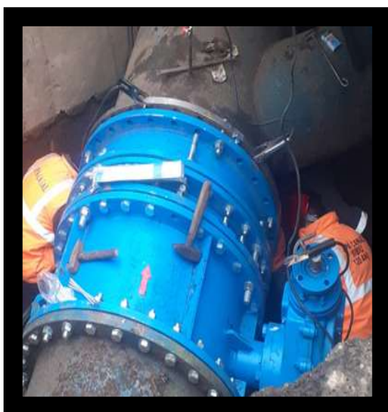
Înlocuire vana DN 1000 mm pe conducta de aducțiune a barajului Gura Râului
