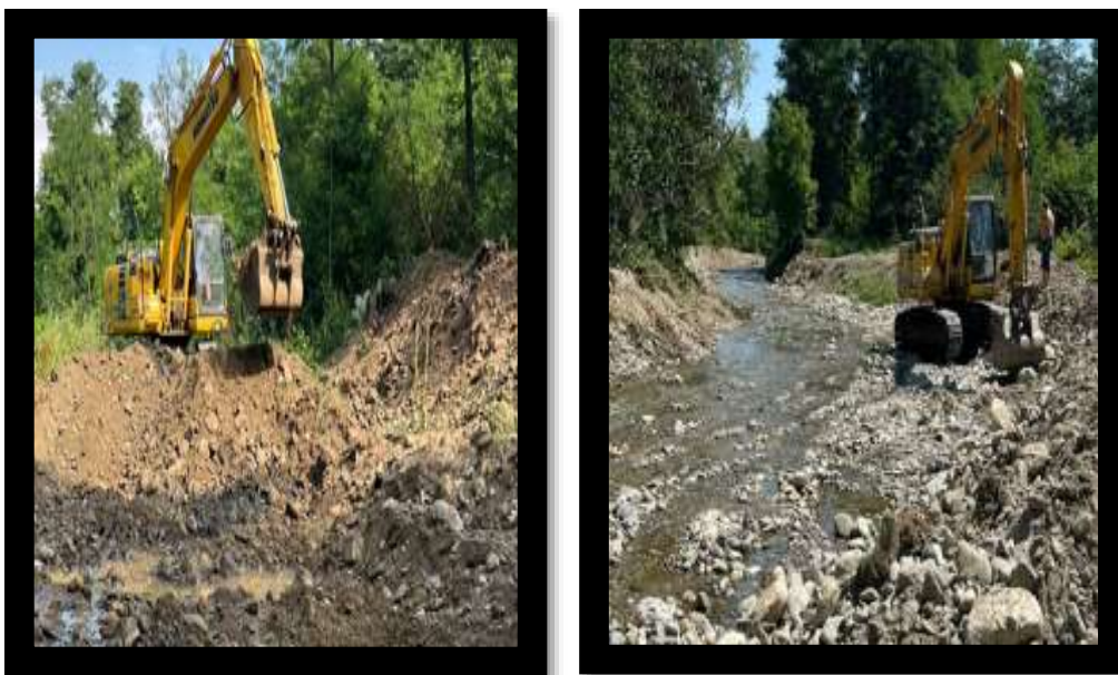
Decolmatare pârâu Bistricioara la Tomșani
