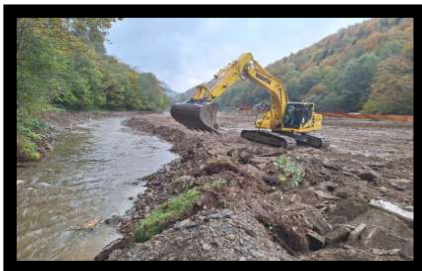
Intervenții corective pr. Bârsa, intravilan Zărnești
