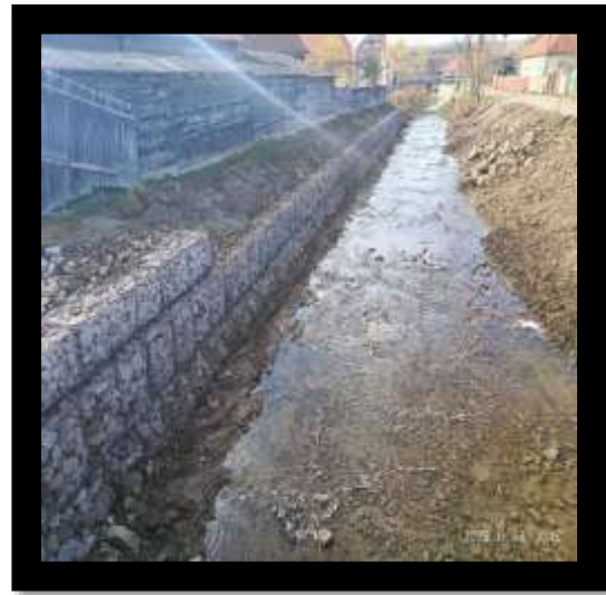
Reparații zid de sprijin din gabioane pe pr. Cașin, mal stâng, amonte SH Plăieșii de Jos, L = 60 ml, hm 417 - 418
