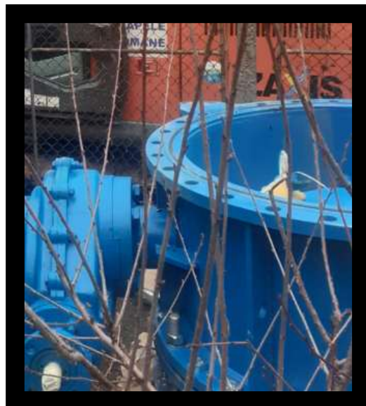
Înlocuire vana DN 1000 mm pe conducta de aducțiune a barajului Gura Râului
