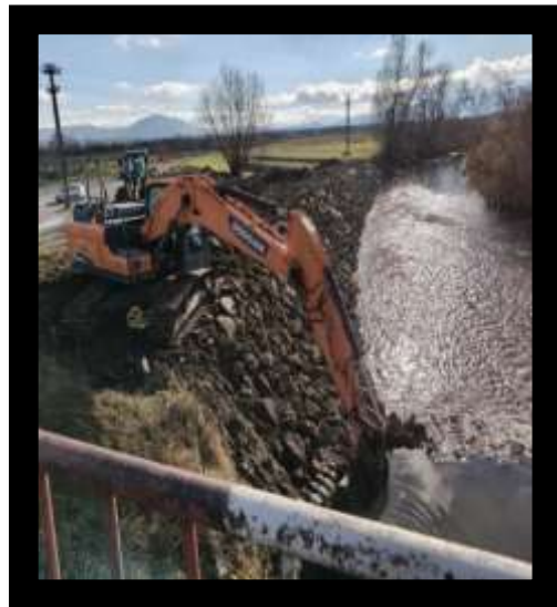
Intervenție corectivă pentru stopare eroziune cu piatră brută, r. Olt, mal stâng, intravilan Siculeni, aval pod, L = 60 ml, hm 5840 - 5841
