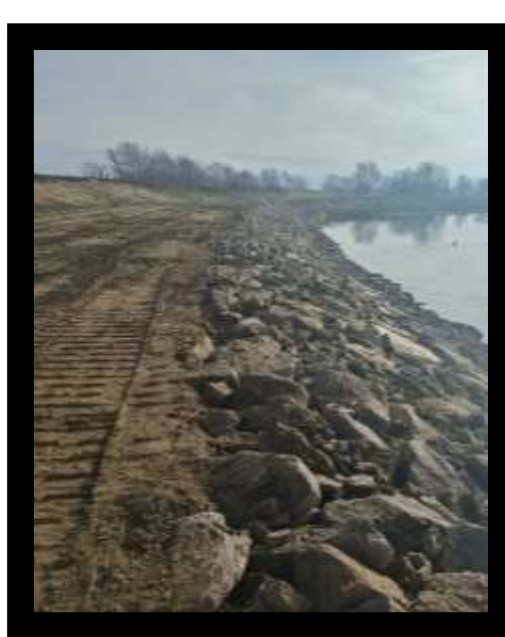
Consolidare cu piatră brută mal drept r. Olt la Căpeni, L =150 m
