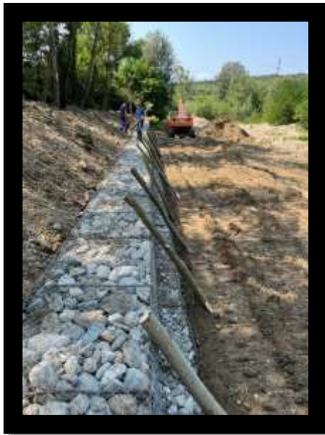
Reparație curentă gabion mal stâng pe pârâu Govora la Mihăești
