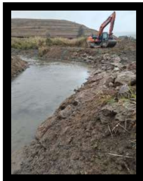
Intervenție corectivă pentru stopare eroziune cu piatră brută, r. Olt, mal stâng - mal drept, amonte loc. Mădăraș, L = 60 ml, hm 5930 - 5931
