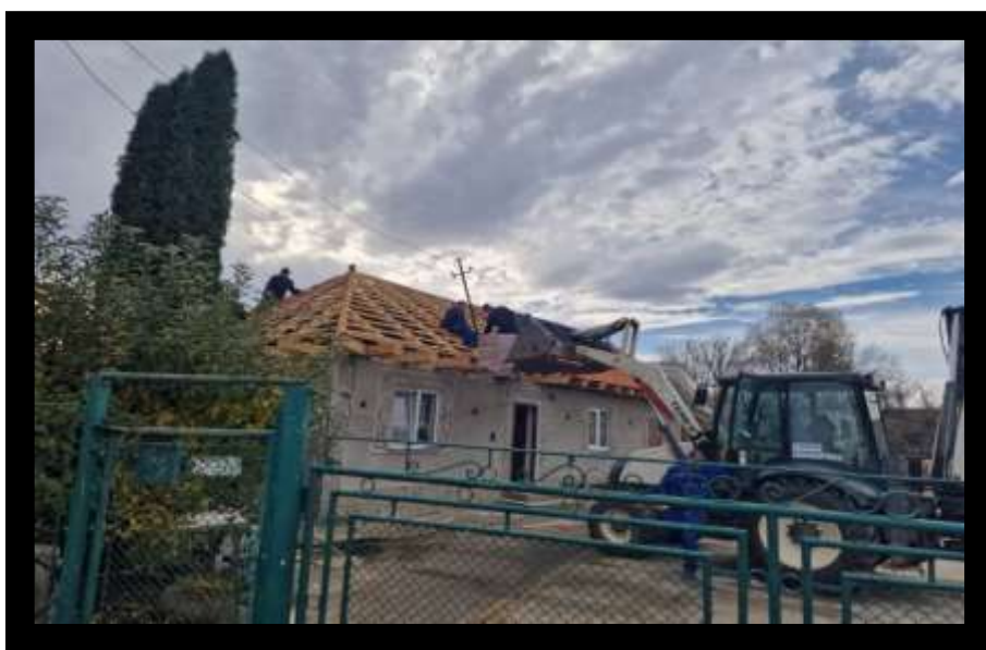
Reparații acoperiș canton Făgăraș
