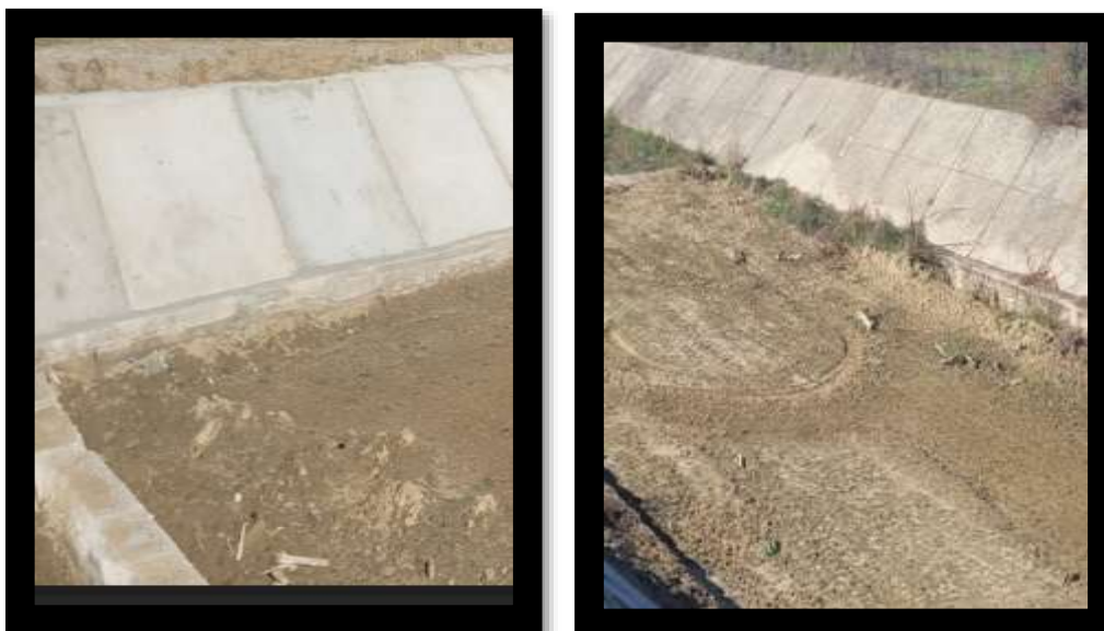
Reparații curente „Regularizare pârâu Roșu la Dobrun”
