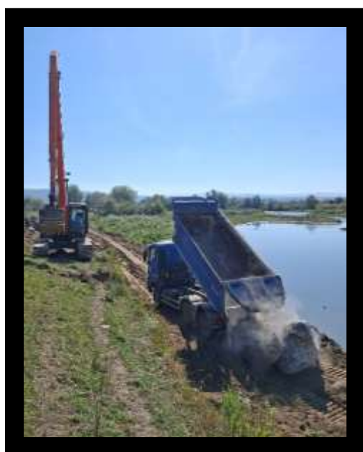
Consolidare cu piatră brută mal drept r. Olt la Căpeni, L =150 m
