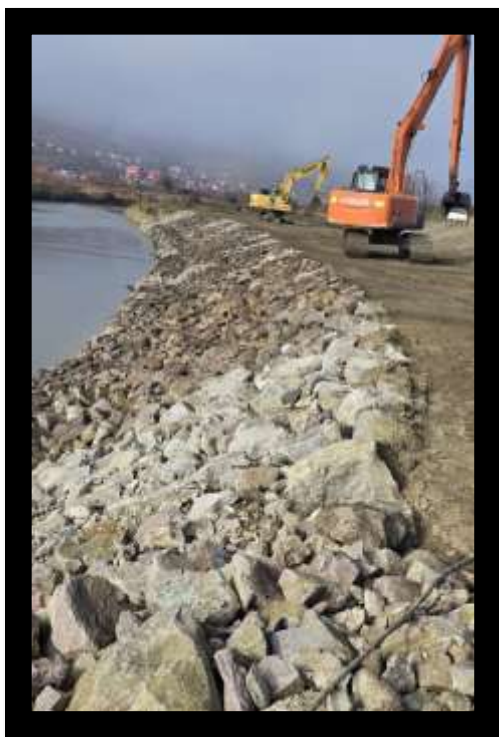
Consolidare cu piatră brută mal drept r. Olt la Căpeni, L =150 m
