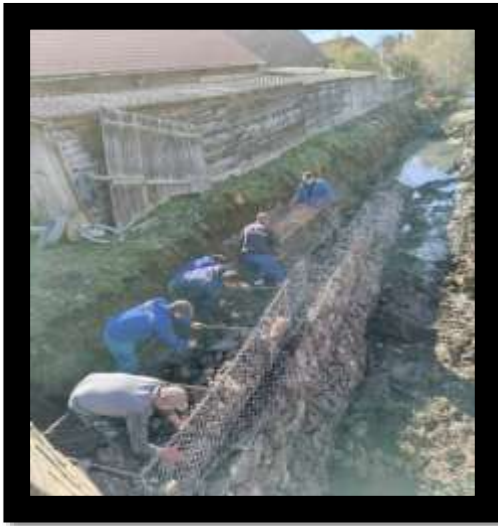
Reparații zid de sprijin din gabioane pe pr. Cașin, mal stâng, amonte SH Plăieșii de Jos, L = 60 ml, hm 417 - 418
